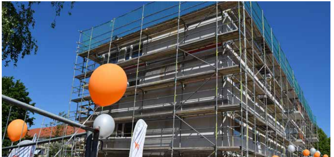
Gemeinsam mit einer Kindergartengruppe aus der gegenüberliegenden Kita feierte die Wohnungsbaugesellschaft „WiD“ mit den Handwerkern, Stadträtinnen und Stadträten und geladenen Gästen den fertig gestellten Rohbau in der Ulmenstraße.
