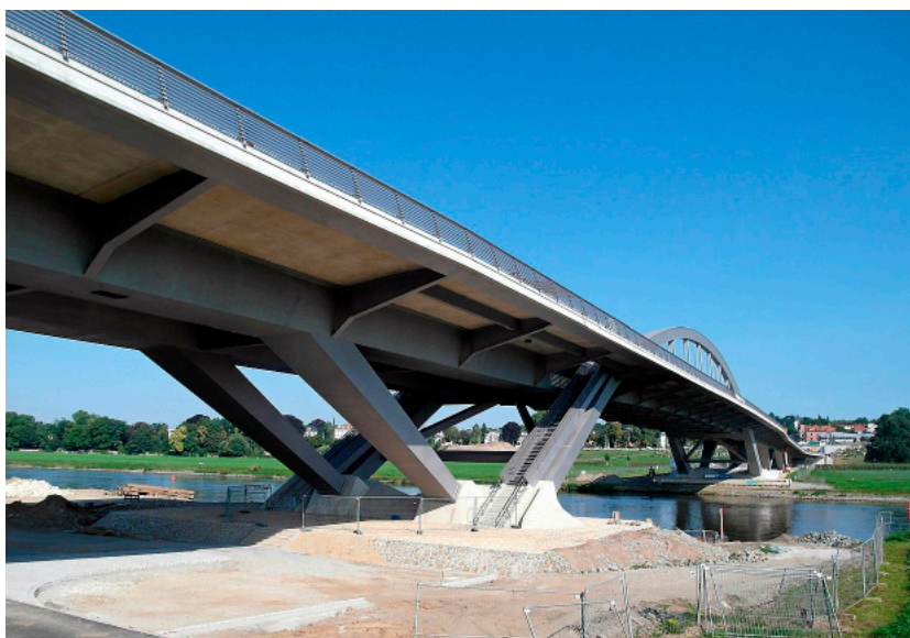
Kostete Dresden den Weltkulturerbetitel: Der Schwarzbau Waldschlößchenbrücke.
