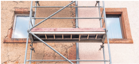
Sanierungen brachten solide Zustände – keinen Luxus.
